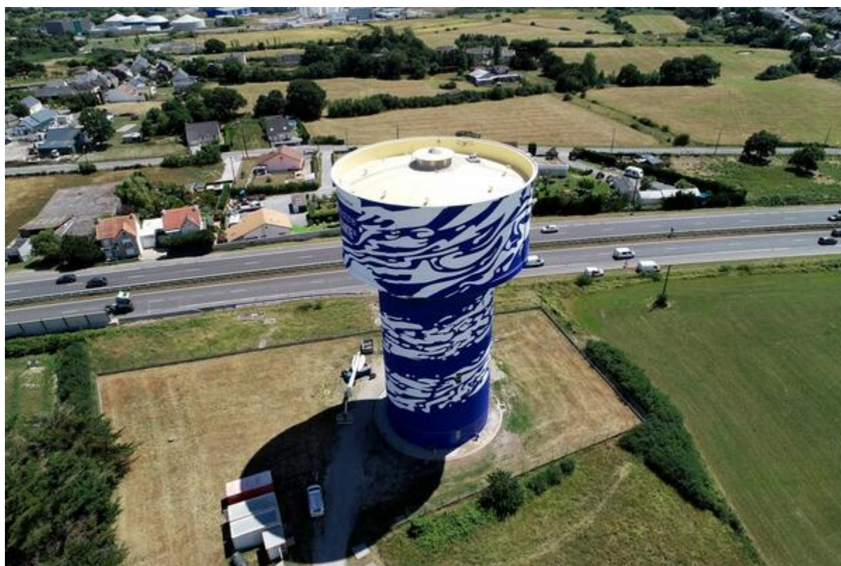
Château d'eau de la Cordonnais
